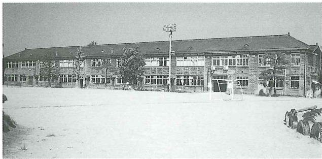
古川第一小学校 南北校舎
