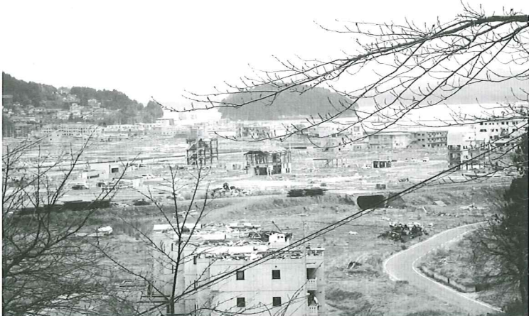
志津川高校前の被災写真
